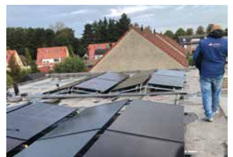
Plaatsen PVT panelen
