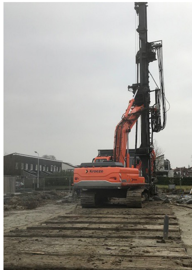
Boorwerkzaamheden Axel, Pironstraat en Marijkestraat
