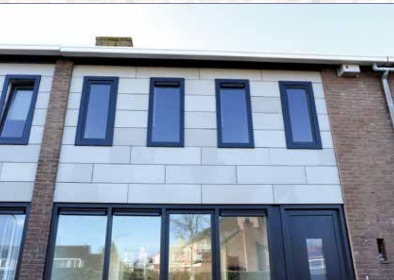
Woongoed Zeeuws-Vlaanderen koos voor de renovatie een duurzaam materiaal: vlas.
